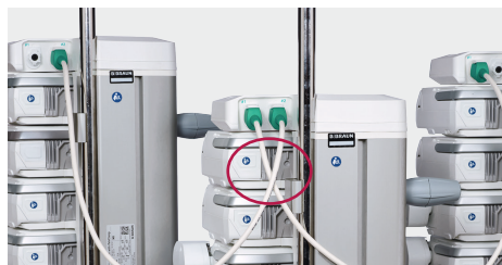
Figure 3: Nesprávné spojení tří stanic, kabely se kříží.
